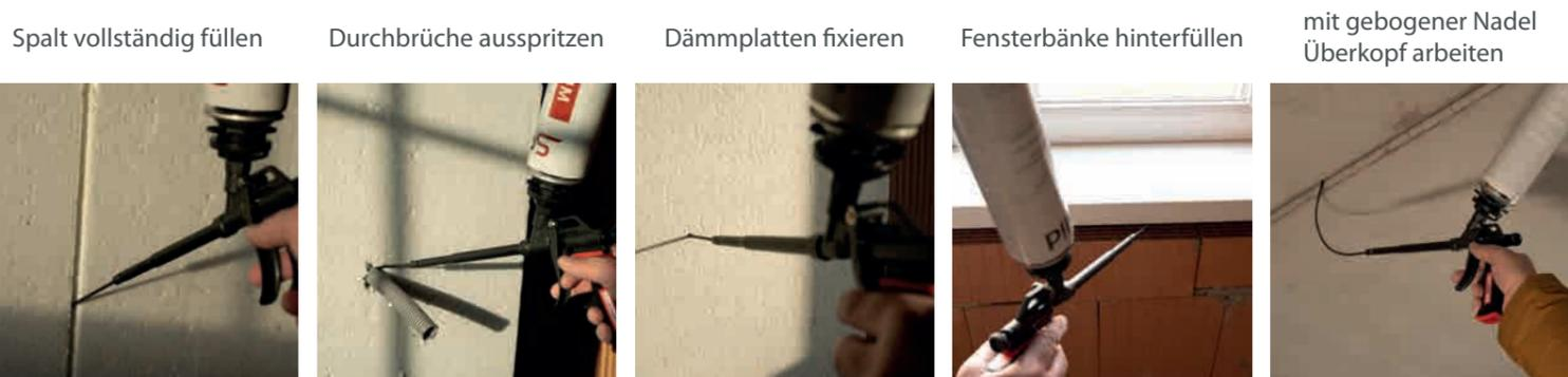
Spalt vollständig füllen    Durchbrüche ausspritzen    Dämmplatten fixieren    Fensterbänke hinterfüllen    mit gebogener Nadel Überkopf arbeiten
