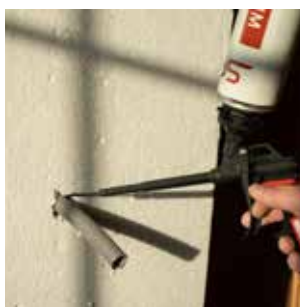
Aplicar material en aberturas
