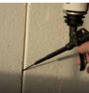
Rellenar completamente el hueco
